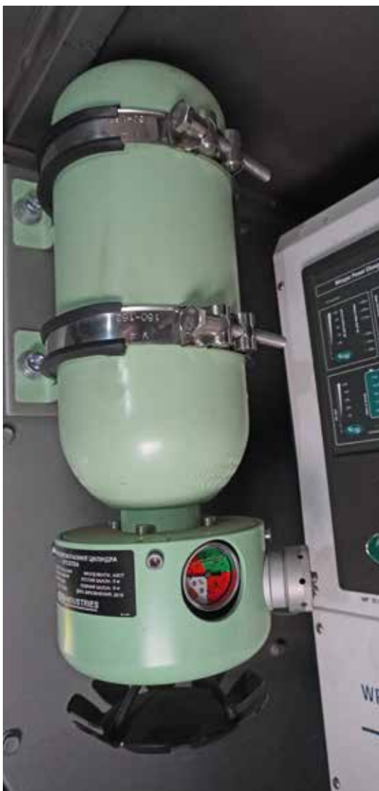
Автономна система пожежогасіння (опція) Stand-alone fire suppression system (optional)
